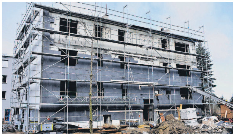
PRZEBUDOWA BUDYNKU PO DPS W GĄSKACH NA MIESZKANIA
